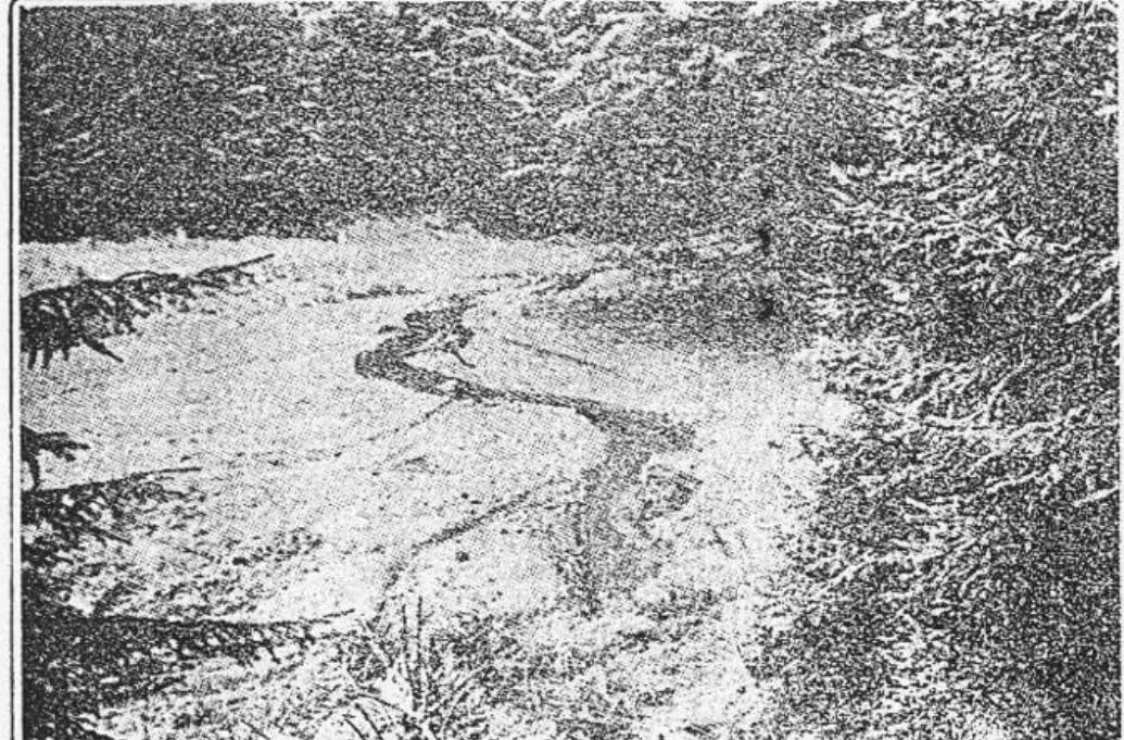
NÁPLAVOU ZANESENÝ RYBNÍK JAKO VÝSLEDEK EROZIVNÍ ČINNOSTI VODY Z NEVHODNĚ PROVEDENÉHO ODVOZNĚNÍ.
