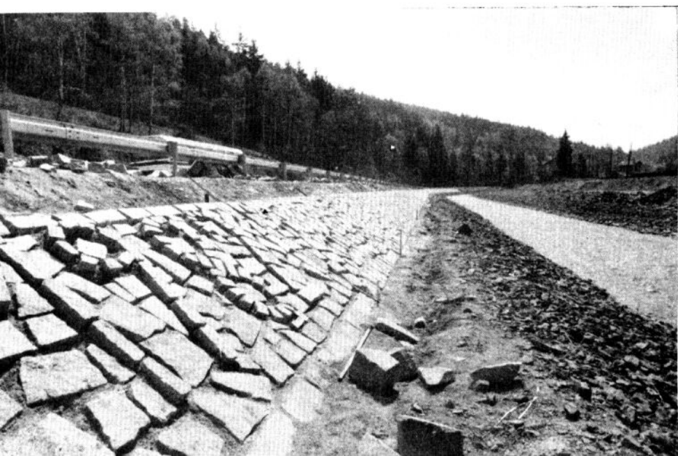
Opevnění břehu Teplé u Krásného Jezu v souvislosti s budováním silnice (foto k příspěvku Poznámka k silnici č.I/24).
