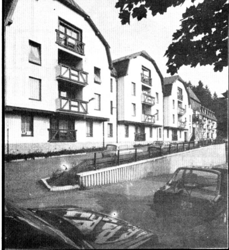
UBYTOVNA DĚVÍN V MARIÁNSKÝCH LÁZNÍCH JE NETYPOVOU APLIKACÍ PANELOVÉ SOUSTAVY T06B
