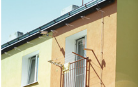
Ukázka citlivé rekonstrukce – řešení umožňujícího hnízdění rorýsů i po zateplení. Bytový dům v Horním Slavkově. Foto Pavla Tájkové.
