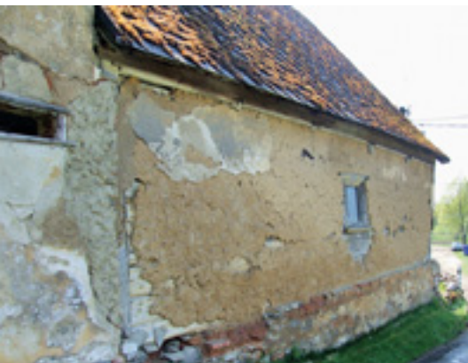
Chotěnov, stěna roubenky s „kožichem“. Foto: Lukáš Hanzl.
