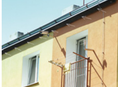
Ukázka citlivé rekonstrukce - řešení umožňujícího hnízdění rorýsů i po zateplení. Bytový dům v Horním Slavkově. Foto Pavla Tájková.
