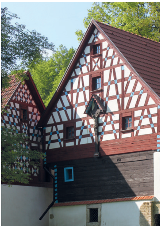
▲ Mlýn po rekonstrukci, na jaře 2013 (jižní strana obytné budovy). Foto Přemysl Tájek.
