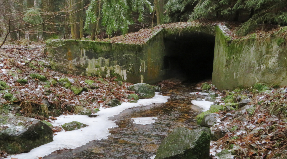
Štola na korytě Komářského potoka u Vlčí.
