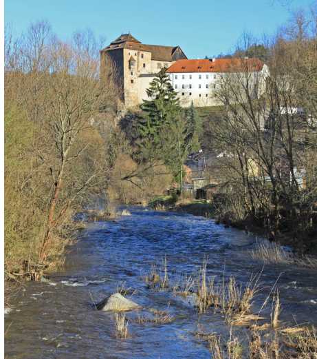
Bečov nad Teplou v roce 2008 a 2018.
