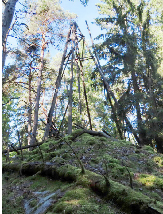
Starý dřevěný triangel na kótě Skalka označující trigonometrický bod geodetické polohové sítě. Foto Jaroslav Frouz.
