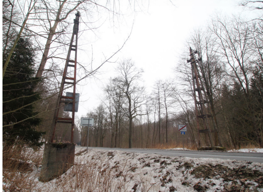
Pohled od jihu na oba železobetonové stožáry u Horního Slavkova dává představu o významu dvojitého jištění vodičů při přechodu přes silnici. Foto Přemysl Tájek.
